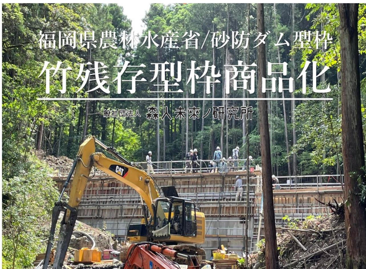
現在治山工事においては、間伐材を利用した杉製残存型枠が主流となっています。
