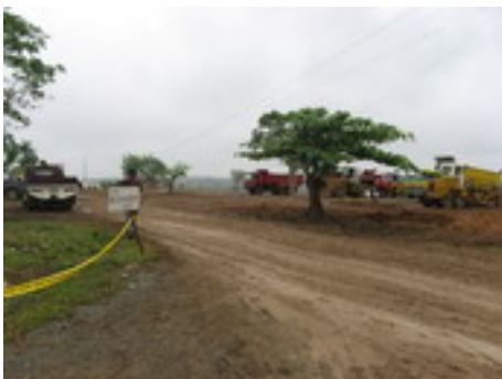
バイオエタノール精製工場の建設現場の様子(2010年11月)
