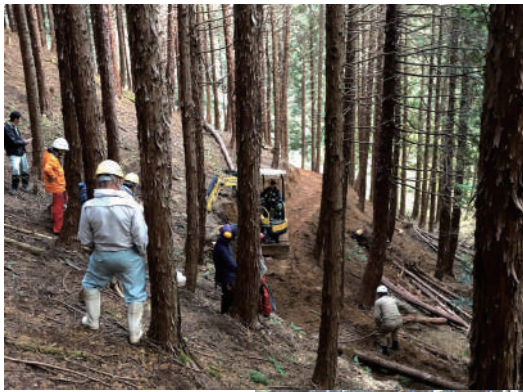
小型機械を使うため2.5m以下の幅狭の道でも作業できる
